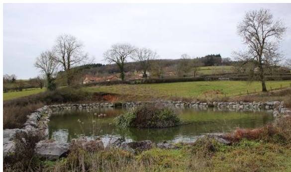
Enrochement et apport d'argile sur les berges de la lagune
