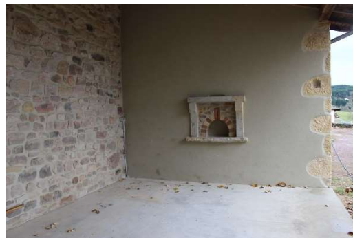
Préau avec création d'une gueule de four
