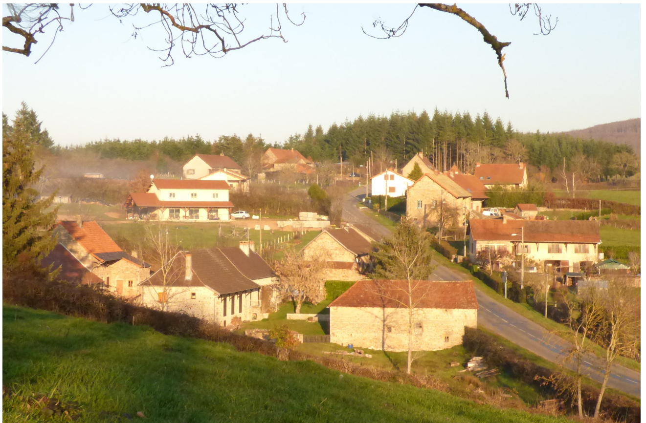
Hameau « Le Murot » Curtil sous Buffières
